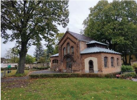
Mitte Oktober sind die Arbeiten am Dach der Friedhofskapelle Sommerfeld abgeschlossen worden. Sowohl das Spitzdach wie auch die beiden seitlichen Dächer wurden grundhaft instandgesetzt. Die Dachdeckung wurde komplett erneuert. Damit konnten wir das Bauwerk für die Zukunft sichern. In einem zweiten Abschnitt der Arbeiten werden die Fenster und Türen überarbeitet. Da wir uns für diese Maßnah-
